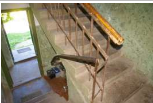
Dzīvojamā ēka ar kadastra apzīmējumu 6478 022 0106 001, koplietošanas telpa
